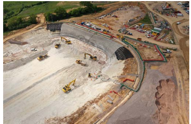
Рис. 14. Вид самой большой строительной площадки на HS2 [31].
